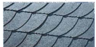
Вид укладки: SCHUPPENDECKUNG Тип плитки: SCHUPPEN
